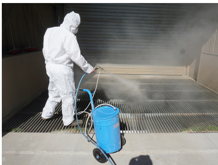
Exemple d'application du FORCEGRAIN MN sur fosse de réception à l'aide de la poudreuse pneumatique à dépression.
